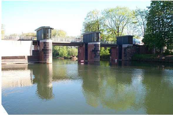
Abb. 4-1: Wehranlage in der Leine bei Hannover mit integriertem Laufwasserkraftwerk (äußerstes linkes Wehrfeld)
