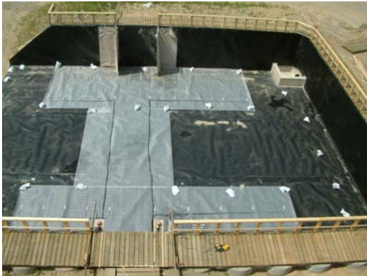
Abbildung 4-2: Lagefester Einbau der Druckmessdosen auf Kunststoffgitter
