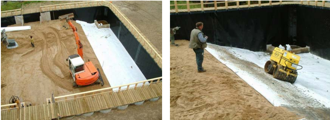
Abbildung 3-14: Einbau der unteren (rechts) und oberen (links) Vliesschicht auf der Wasserseite
