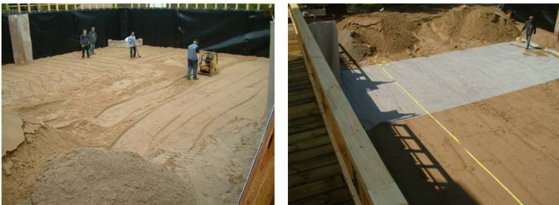
Abbildung 3-12: Ausgleichsschicht über den Dichtungsbahnen
