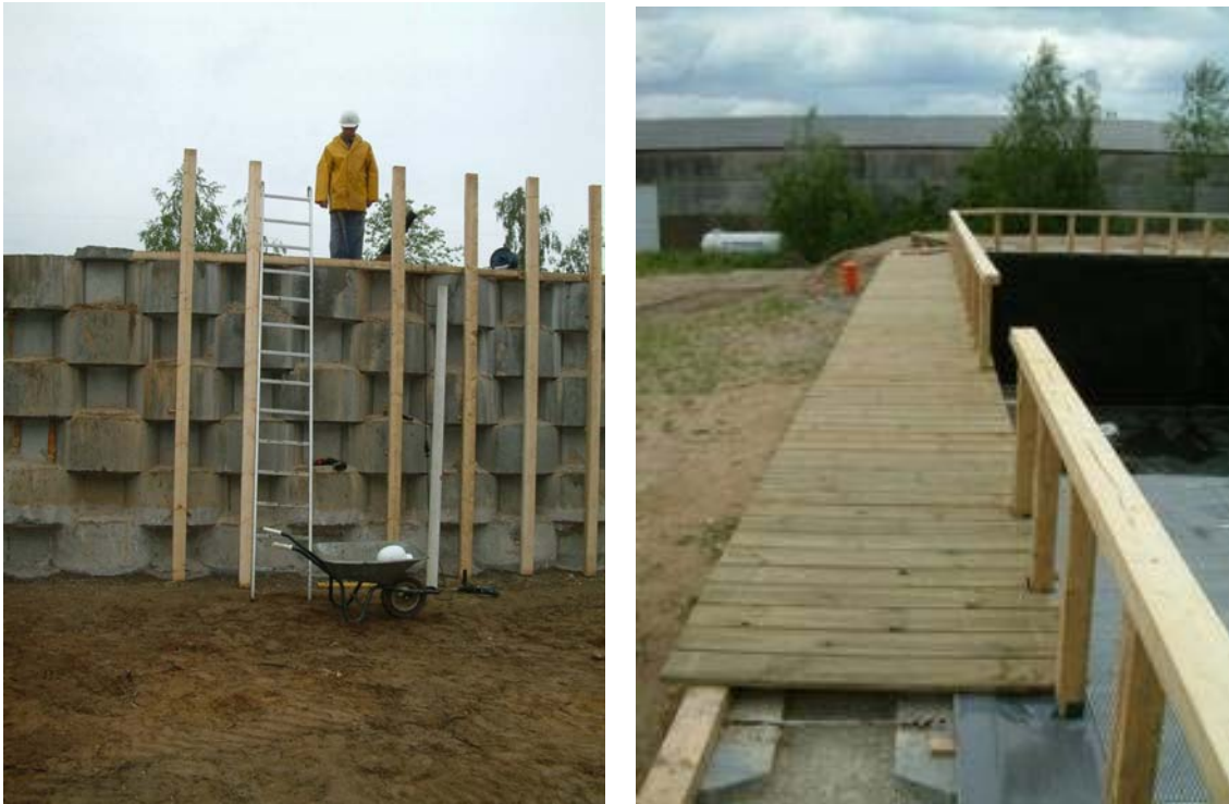
Abbildung 3-5: Unterkonstruktion aus Kanthölzern (links) und Kontrollsteg (rechts)
