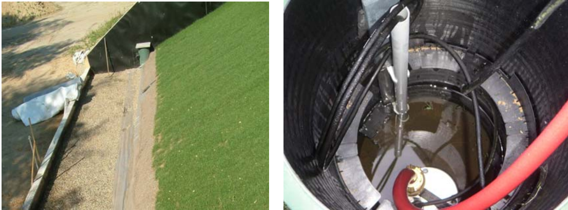
Abbildung 3-18: Böschungfußdränage mit Vliesummantelung und Kontrollschächten
