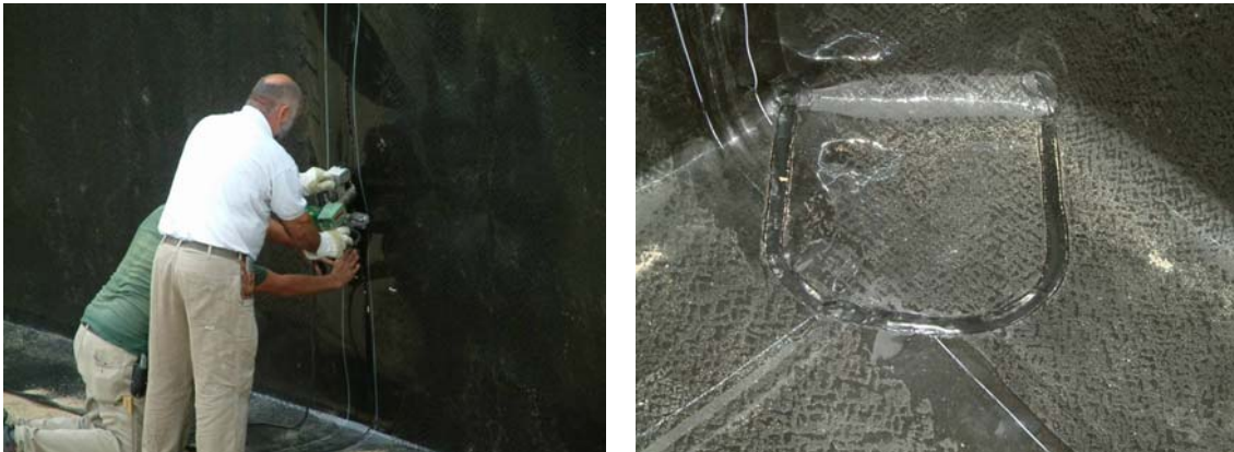
Abbildung 3-9: Heizkeilschweißnaht (links) und Extrusionsschweißnaht (rechts)
