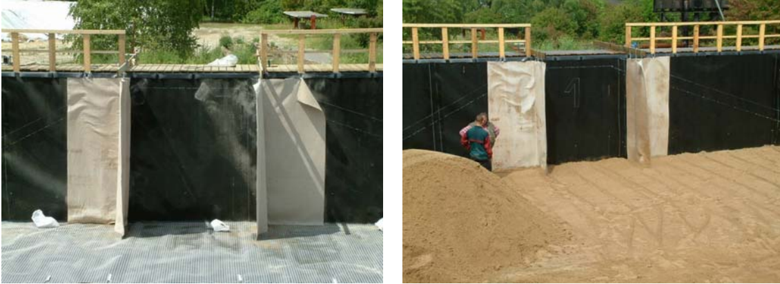
Abbildung 3-11: Bentonitmatten im Kronenbereich des Deiches vor (links) und während des Einbaus (rechts)
