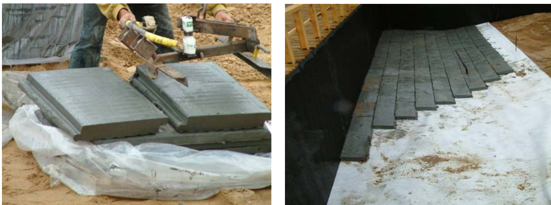
Abbildung 3-15: Dichtungselemente aus Naturton
