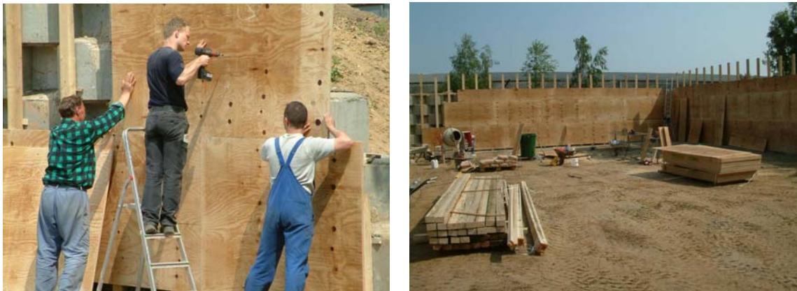
Abbildung 3-6: Anbau der Seekieferplatten an die Unterkonstruktion
