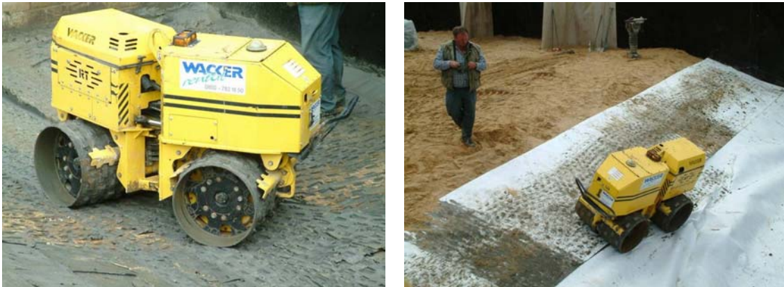
Abbildung 3-16: Verdichtung der Dichtungselemente mittels Schafffußwalze
