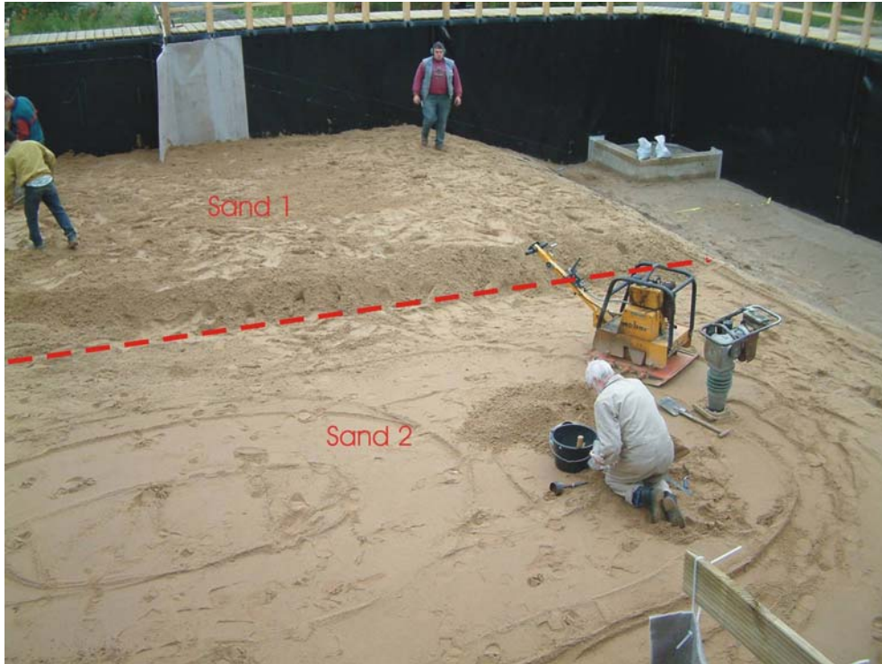
Abbildung 3-13: Schichtweiser Aufbau des Sandkerns; Probenahme
