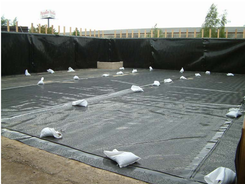
Abbildung 3-8: Wannendichtung aus verschweißten Kunststoffdichtungsbahnen
