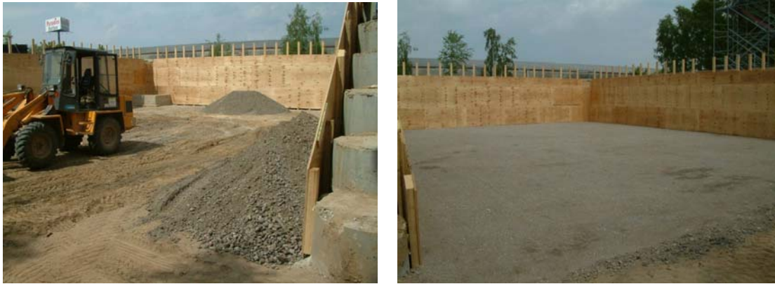
Abbildung 3-7: Herstellung des Planums aus Mineralgemisch 0/32
