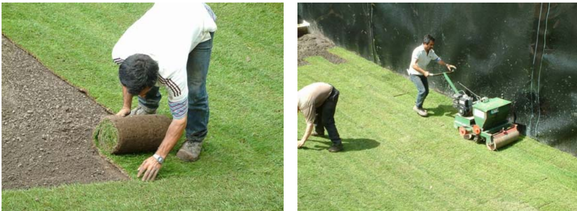
Abbildung 3-17: Verlegung und Anwalzen des Rollrasens
