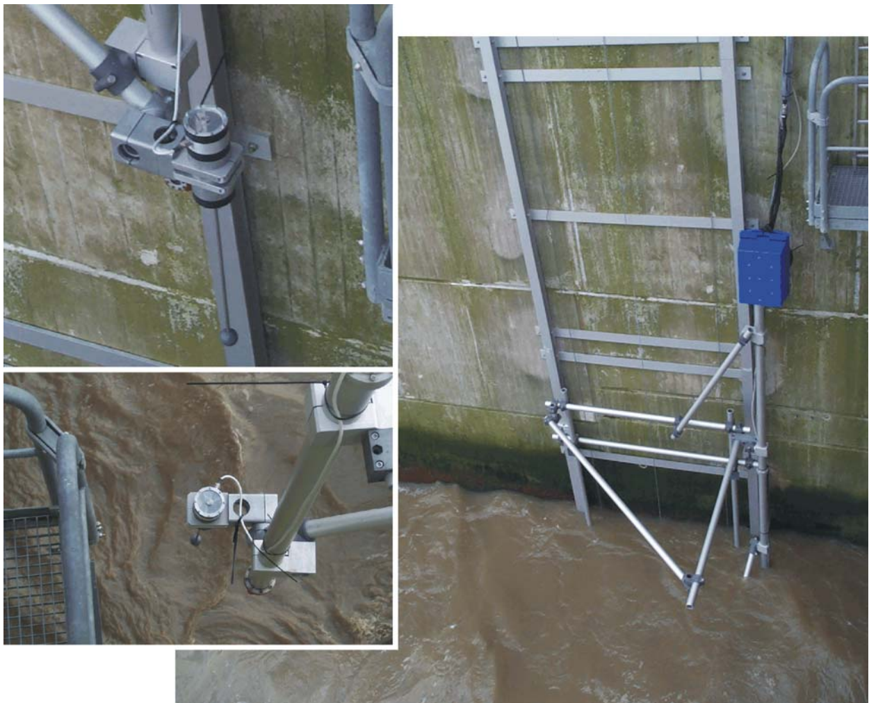
Abbildung 3-3: Anströmkörper-Strömungsmesssystem am Emssperrwerk
